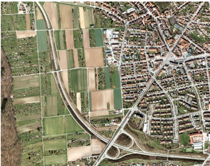
Abb. 7/1 Umfahrungsstraße (Ortsumfahrung Stuttgart-Weilimdorf)
