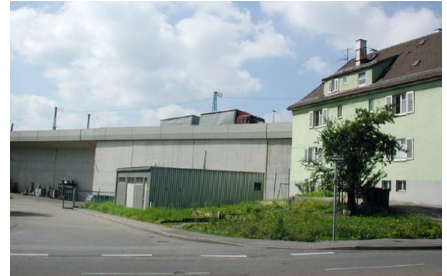
Abb. 7/21 Abschirmung durch Hochlage
