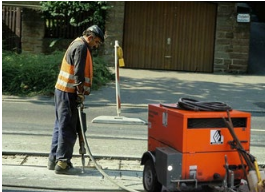
Abb. 2/7 Beispiel einer Punkt- bzw. Linienschallquelle
